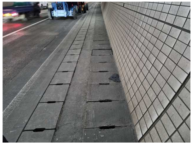
공동구 및 배수로 전경
